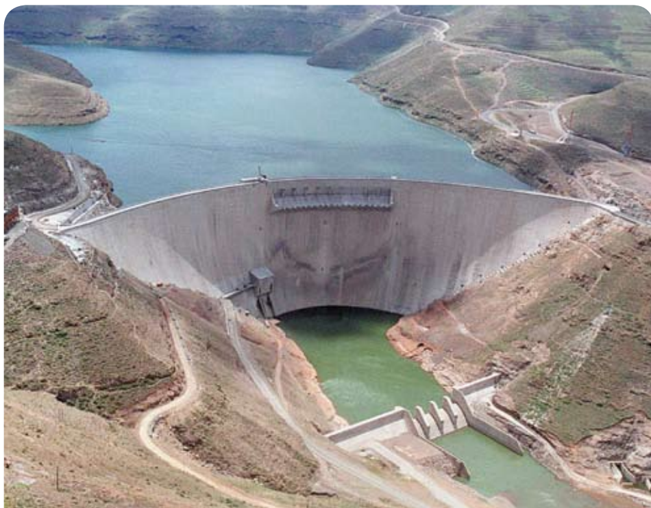
Barrage de Katse au Lesotho : la réforme de la gestion des finances publiques doit viser à incorporer davantage les projets financés par les bailleurs de fonds dans le budget.
